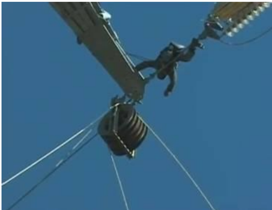
Рисунок 8.12 – Крепление раскаточного ролика к траверсе опоры
