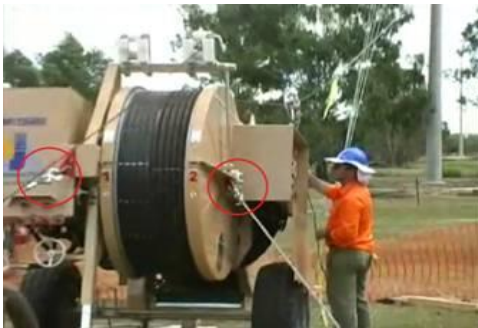
Рисунок 8.10 – Установка тормозной машины – точки крепления якоря к тормозной машине спомощью стального троса
