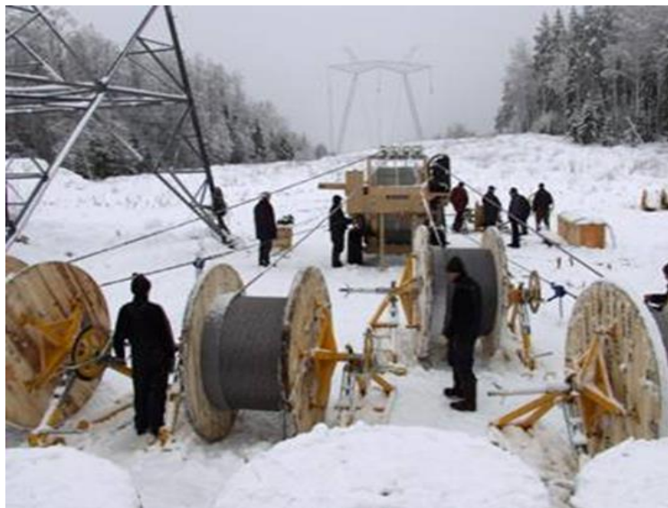
Рисунок 8.11 – Размещение оборудования в начале участка ВЛ
