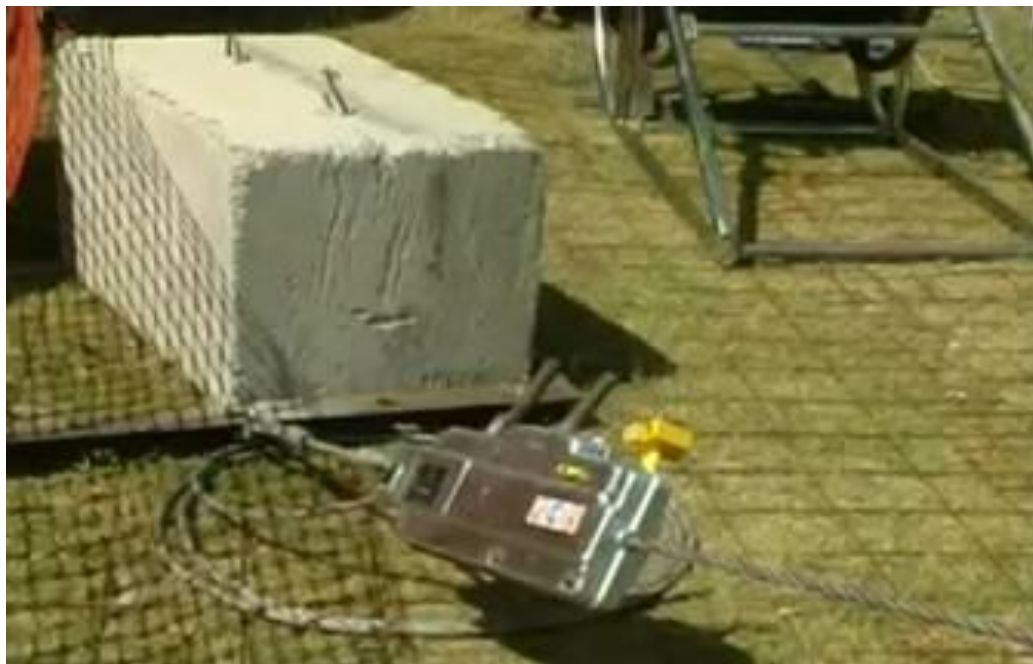
Рисунок 8.9 – Установка тормозной машины – временный якорь
